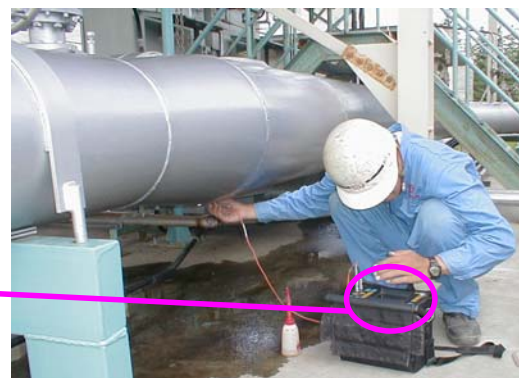
配管内水位測定状況
