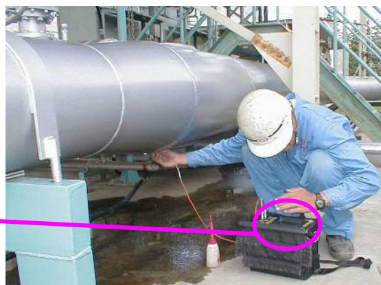
配管内水位測定状況
