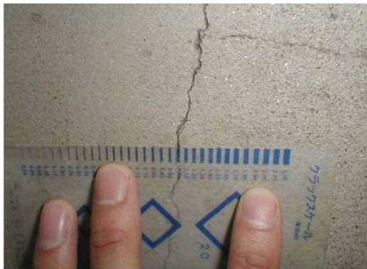
クラックスケールによるひび割れ幅の測定
